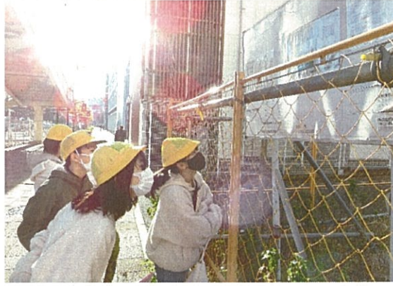
歩道橋の工事進捗状況を確認する児童の様子
