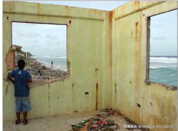
▲ 高波で壊された民家 (マーシャル諸島イバイ島) 出典：JCCAウェブサイトから引用
