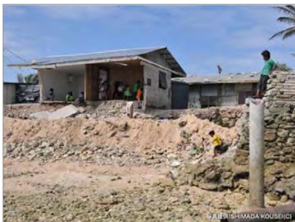
▲ 高波で壊された民家 (マーシャル諸島マジュロ島) 出典：JCCAウェブサイトから引用
